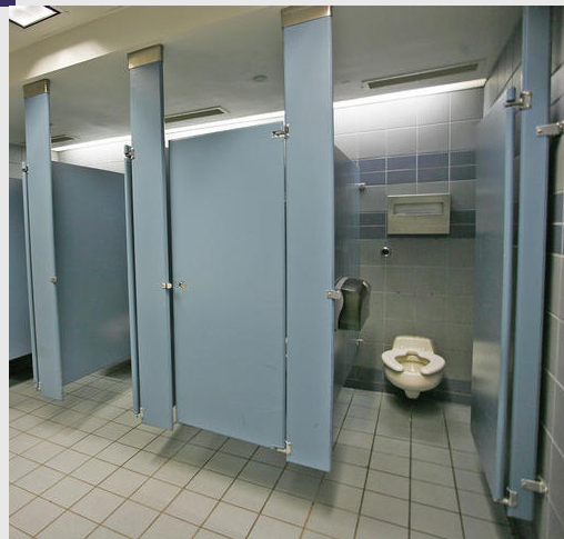
Imagen N° 32: Baños con materiales de terminación de alta resistencia, divisiones de cabinas con espacio libre de 30 cm. desde el suelo y artefactos empotrados a muro.
