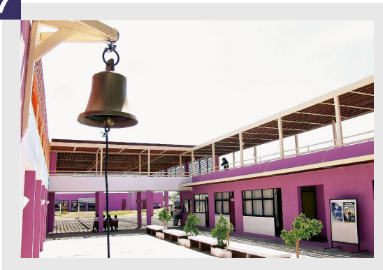
Imagen N° 21: Galerías de circulación en el perímetro. Liceo Padre Alberto Hurtado Cruchaga - Pica.
