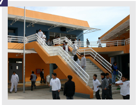
Imagen N° 34: Desarrollo lineal de escalera con contrahuellas opacas permite fluidez en desplazamiento y control visual de recorridos. Escuela de Deportes Gualberto Kong Fernández - Vallenar.
