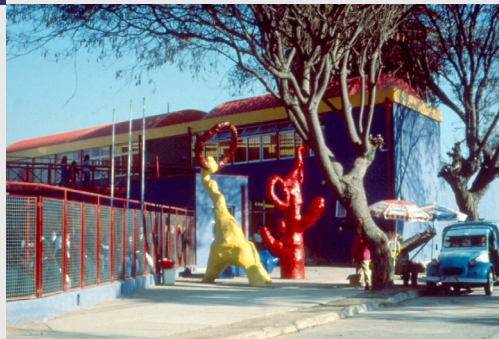
Imagen N°17: Espacios de encuentro, reforzando el espacio público circundante con una obra de arte. Colegio Buen Pastor - Copiapó.
