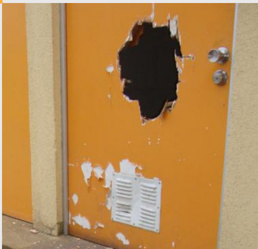
Imagen N° 39: Materialidad de hojas de puerta de placa sin relleno macizo en cuerpo interior.
