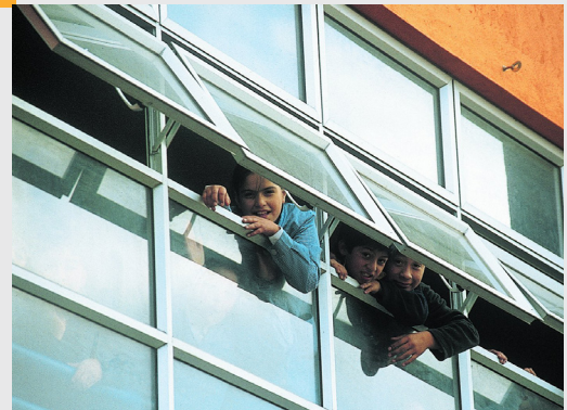
Imagen N° 42: Aperturas de vanos angostas para ventilación. Escuela Padre Alberto Hurtado - Puerto Montt.
