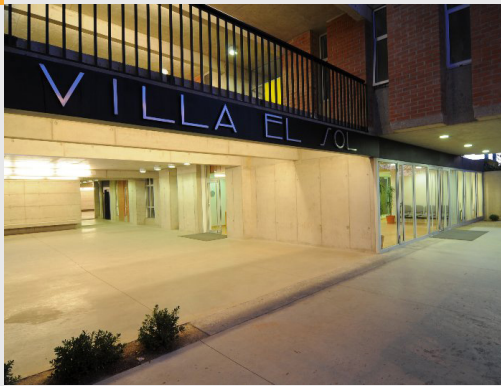
Imagen N° 44: Iluminación permanente en zonas de circulación. Colegio Villa El Sol - El Bosque, R. Metropolitana.
