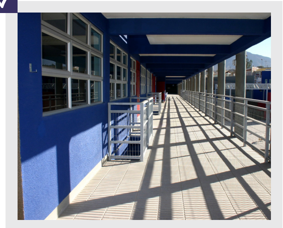
Imagen N° 33: Pasillos con control visual expedito, posee franja distanciada de muro que permite salida expedita desde salas. Escuela Básica Villa Los Salares - Copiapó.
