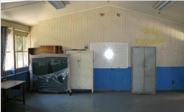
Imagen N°19: Sala de clase con muros cerrados u opacos, que impiden la visibilidad y vigilancia natural hacia y desde el exterior.
